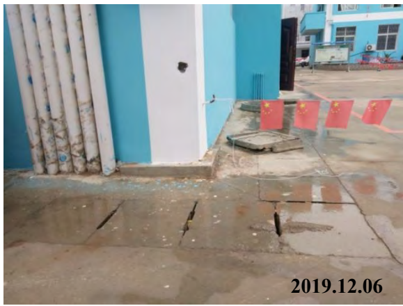
院内雨水收集沟渠
