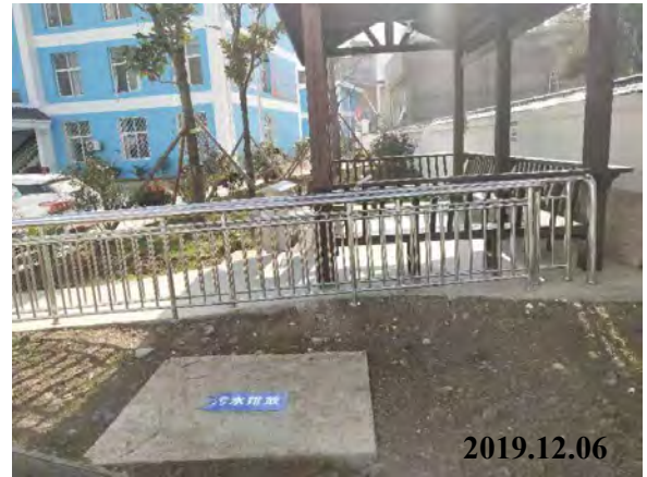
污水总排放口
