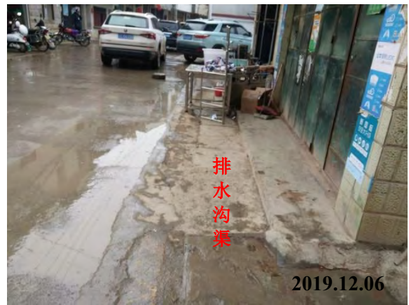
集镇街道雨污合流沟渠
